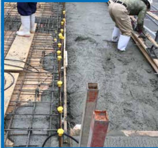
1階部分のコンクリート打設から2～3日間の養生後、2階部分の木軸建込みをスタートし、以降、1階部分と同様の工程で進行していきます。
