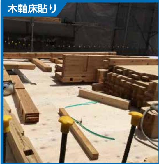
木軸の外側には壁ボードを貼り、内側には断熱材（厚み 105 mm）とコンクリート打設用仮胴縁（200 ~ 300mmピッチでビス止め）を配置し、これらを一体として内部型枠の代わりにさせます。
