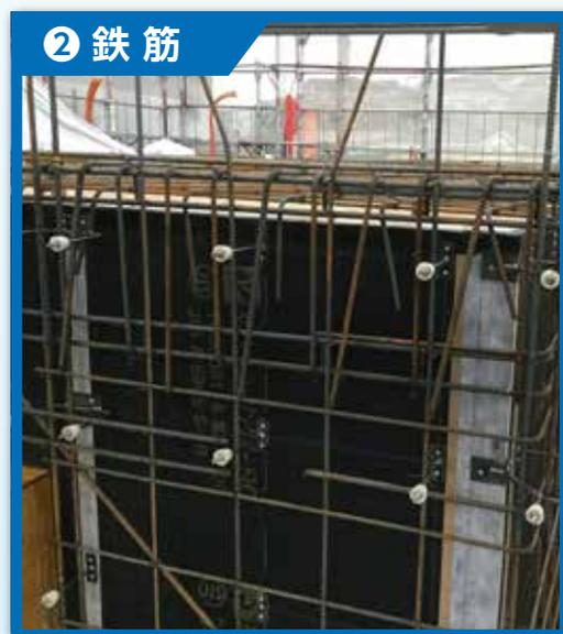
**ダブルフレーム工法 (木造 + 鉄筋コンクリート)**
